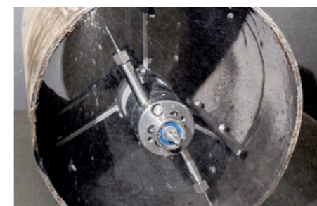
Limpieza de tuberías
