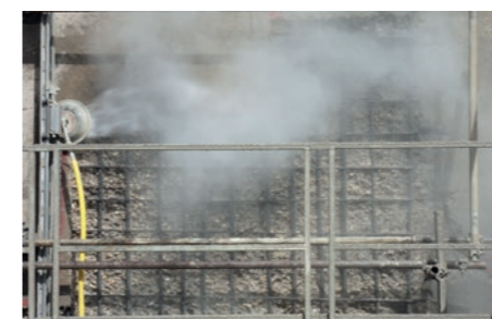
Rehabilitación de hormigón
