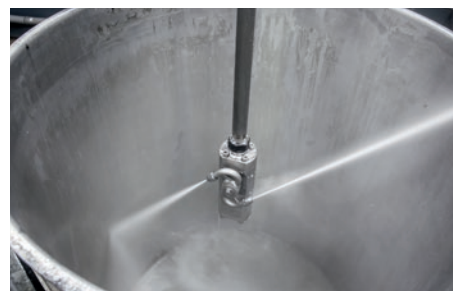
Nettoyage de réservoirs
