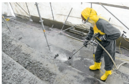
Hydrodémolition de béton
