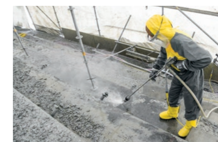
Rehabilitación de hormigón
